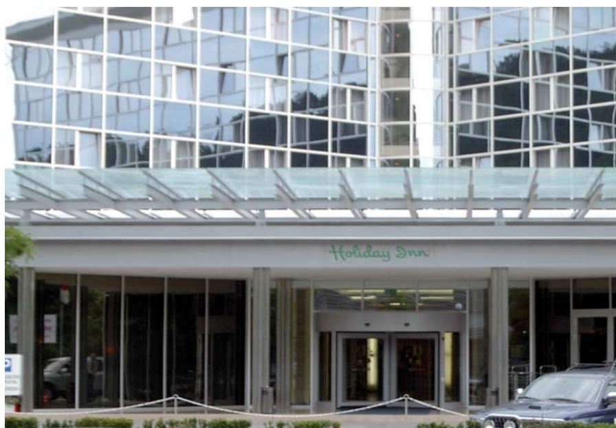
Рис. 1. Окраска металлоконструкций краской Temadur 50 THL.
