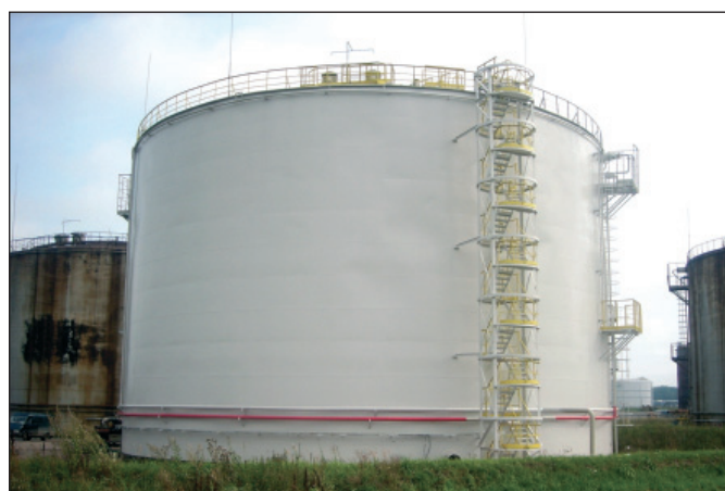
Фото 3 и 4. Ремонтная окраска конструкций агрегатов газоперекачивающих станций выполнена с применением лакокрасочных материалов ООО «Гамма Индустриальные Краски». Применение системы покрытий на базе грунтовки, толерантной к подготовке поверхности, для окрашивания металлоконструкций сложной формы и в нестабильных погодных условиях — оптимальное техническое решение
