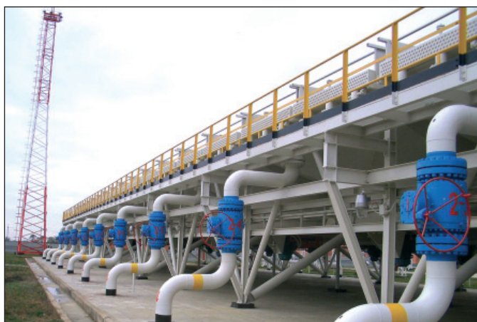
Фото 3 и 4. Ремонтная окраска конструкций агрегатов газоперекачивающих станций выполнена с применением лакокрасочных материалов ООО «Гамма Индустриальные Краски». Применение системы покрытий на базе грунтовки, толерантной к подготовке поверхности, для окрашивания металлоконструкций сложной формы и в нестабильных погодных условиях — оптимальное техническое решение
