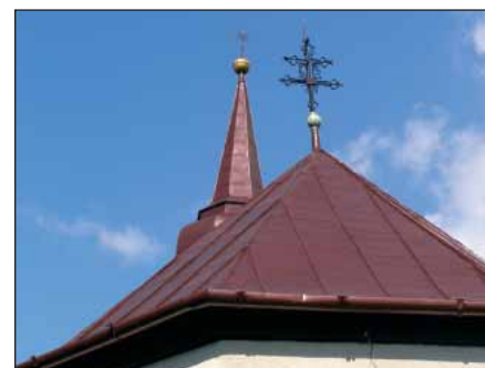
Фото 1. Купол церкви, окрашенный краской Темадур 90 перламутрового оттенка
