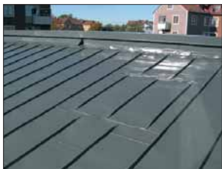
Фото 2. Окрашенная алюминиевая кровля жилого здания
